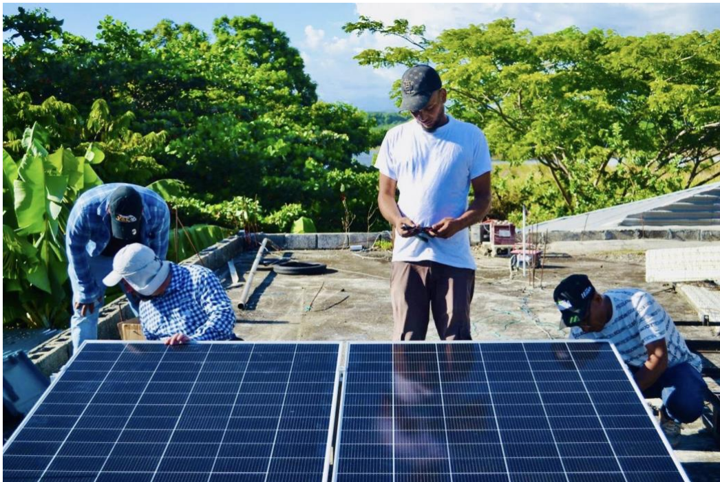
Una comunidad de Nizao, en la República Dominicana, instala paneles solares sobre techo
