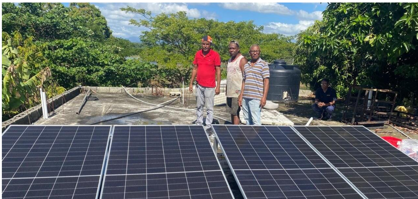
Un grupo de vecinos posando tras instalar un sistema de solar sobre techo en la República Dominicana
